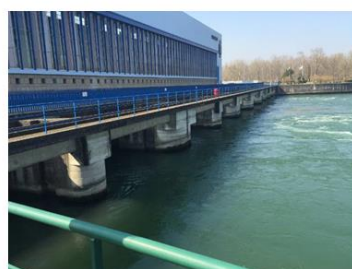
Vue depuis l'aval des cloisons intermédiaires
