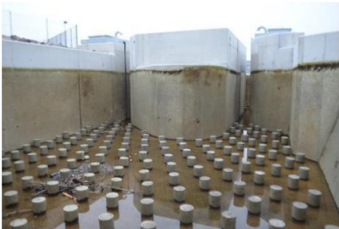
Figure 45 – macrorugosités de fond au local de comptage de Kembs
