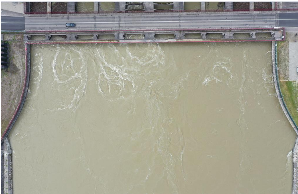
Figure 22 – Vue aérienne zénithale de l'écoulement en aval de l'usine de Marckolsheim
