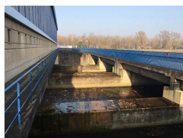
Vue des alvéoles et des cloisons intermédiaires entre la route et l'usine – vue du bajoyer des déchargeurs
